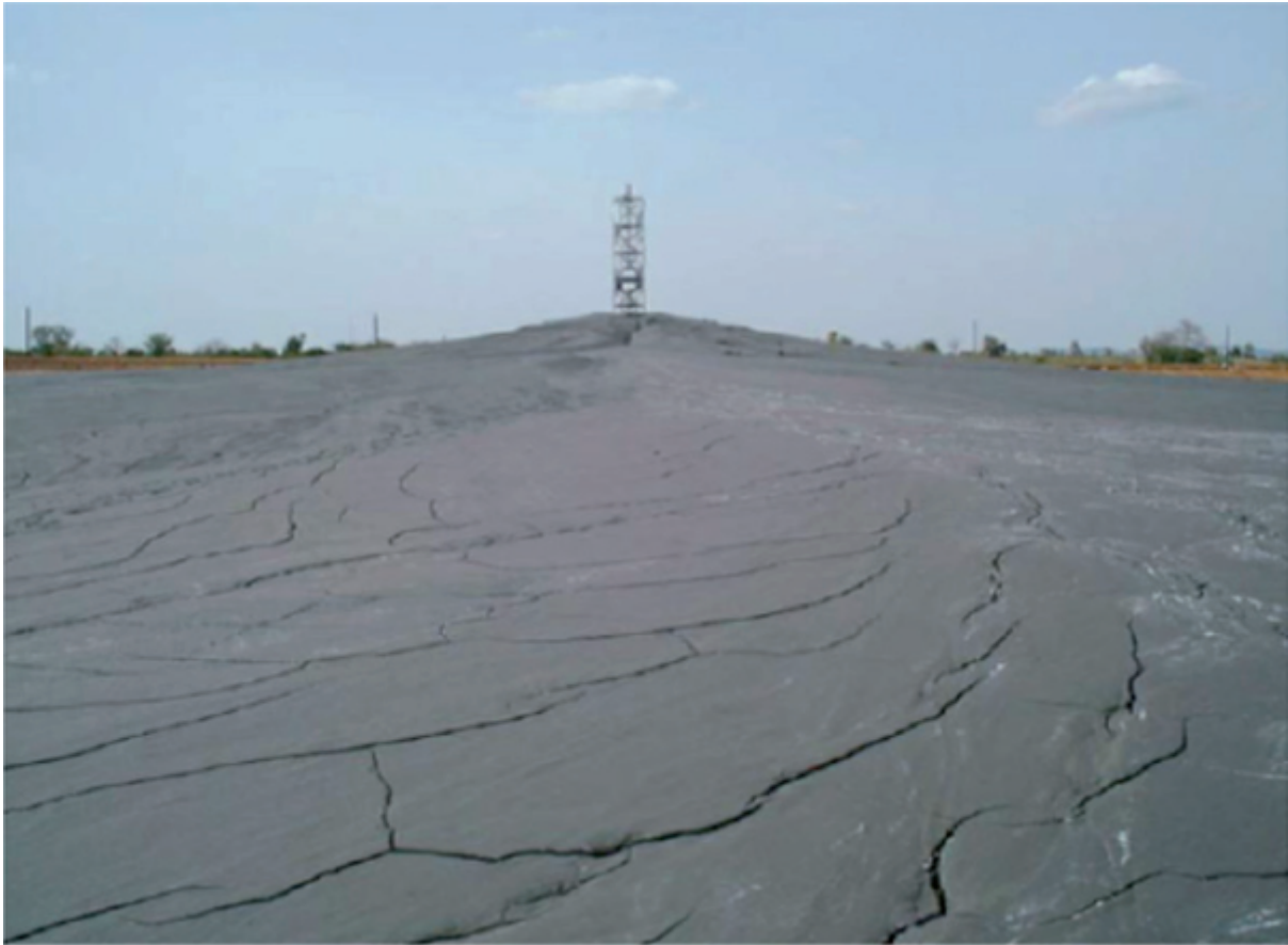
Figura 3.30 Vertido de Lodos Espesados; la Torre que se Aprecia al Fondo es el Punto de Vertido.
