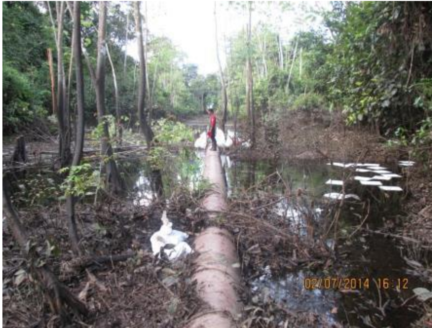
Paños absorbentes dispersados en la superficie del agua sobre el canal del oleoducto
